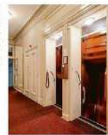
Unikátní výtah Rekonstrukce páternoster v Petšchově paláci napomohla na ocenění nakonec nespomněnka. Foto: Euro Výtahy
